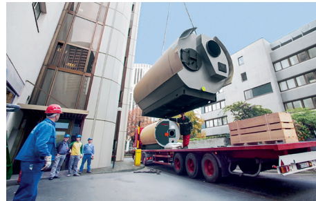
Anlieferung eines Kessels auf der Baustelle
