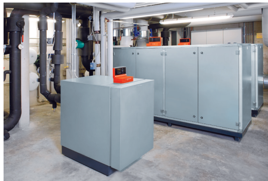
Wärmepumpen Vitocal 300-G PRO (rechts) und Vitocal 300-G (links)
