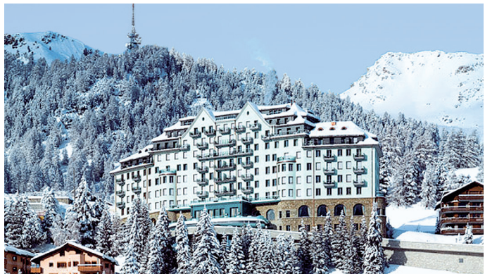
Im 5-Sterne-Hotel Ritz Carlton in St. Moritz wird das Abwasser zur Wärmegewinnung genutzt.
