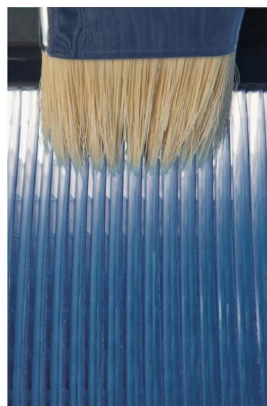
Einfache Wartung des Wohnungslüftungssystems (hier am Beispiel des Vitovent 300-W): Sichtkontrolle der Filter (o. l.) und Filterwechsel bei starker Verschmutzung. Der Wärmetauscher kann mittels Pinsel, Staubsauger oder unter einem Brausestrahl gereinigt werden.
