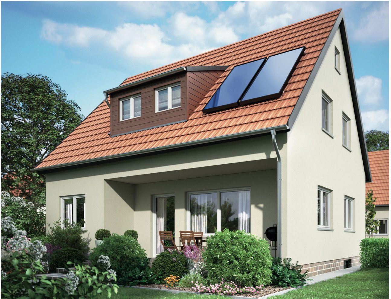
Vitosol 200-FM auf dem Dach eines Einfamilienhauses
