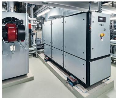
Das 500 Wohnungen umfassende Rosensteinquartier in Stuttgart besticht durch ein zukunftsweisendes Heiz-, Kühl- und Stromkonzept und setzt dabei auf Sektorkopplung. Im Untergeschoss der modernen Wohnanlage ist die Heizzentrale untergebracht. Deren Herzstück besteht aus einem Blockheizkraftwerk Vitobloc 200 EM-50/81.
