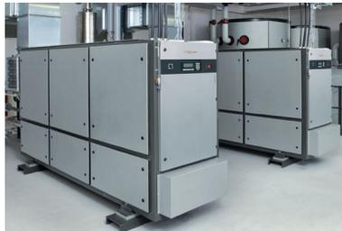
Zwei Blockheizkraftwerke tragen in einem Holzwerk in Bayern zu einem nachhaltigen Betrieb bei - sie erbringen je  $140 \text{ kW}_{el}$  und  $207 \text{ kW}_{th}$  Leistung.
