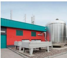
Im Heizkraftwerk der Stadtwerke Güstrow sind zwei mit Biogas betriebene Blockheizkraftwerk-Module Vitobloc 200 EM-140/207 installiert, die Wärme und Strom für 500 Haushalte erzeugen.
