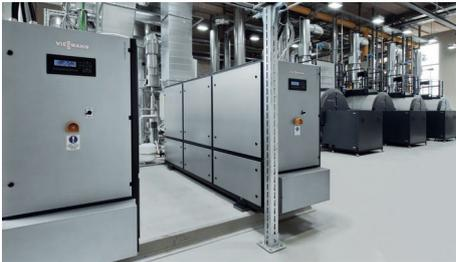
Die Energiezentrale des Blauhauses in Mönchengladbach dient unter anderem zu Studienzwecken für die nahe gelegene Hochschule - installiert sind hier eine Sole/Wasser-Wärmepumpe Vitocal 300-G PRO mit Eisspeicher-System sowie ein Blockheizkraftwerk Vitobloc 200 EM-6/15 für die zusätzliche Wärme- und Stromversorgung.
