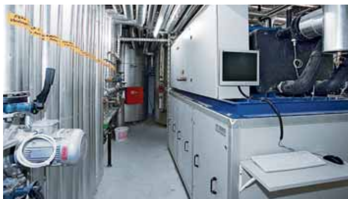
Diese Abwasser-Wärmepumpe mit einer Leistung von 150 kW wird zur Trinkwassererwärmung genutzt.
